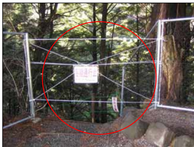
駐車場側施行後
